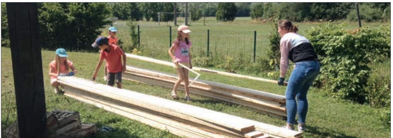
Construction d'une cabane
