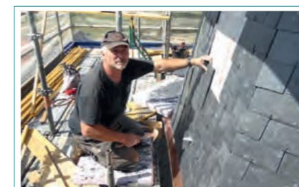
Mise en place de tuiles en ardoise
